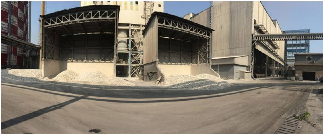
Şekil 3. Kardemir A.Ş. kireç fabrikasında bulunan kireç taşı yer altı bunkerleri genel görünümü
