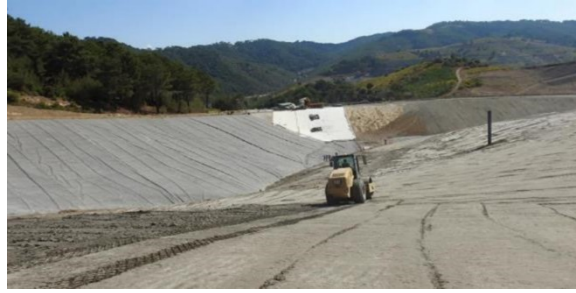
Şekil 25. Dozerle yapılan serimin ardından silindirin sıkıştırma işlemi yaparak alanın yüzey pürüzlülüğünü yok ederek kabuk oluşturması
