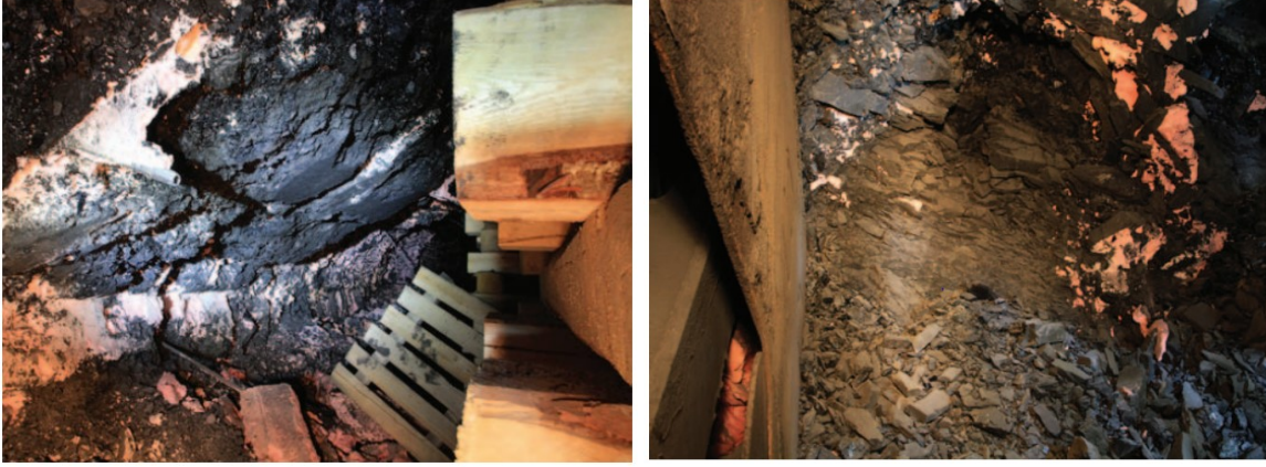
Şekil 3: Kimyasal köpük uygulamaları ile göçük stabilizasyonu (Pile, 2013)
