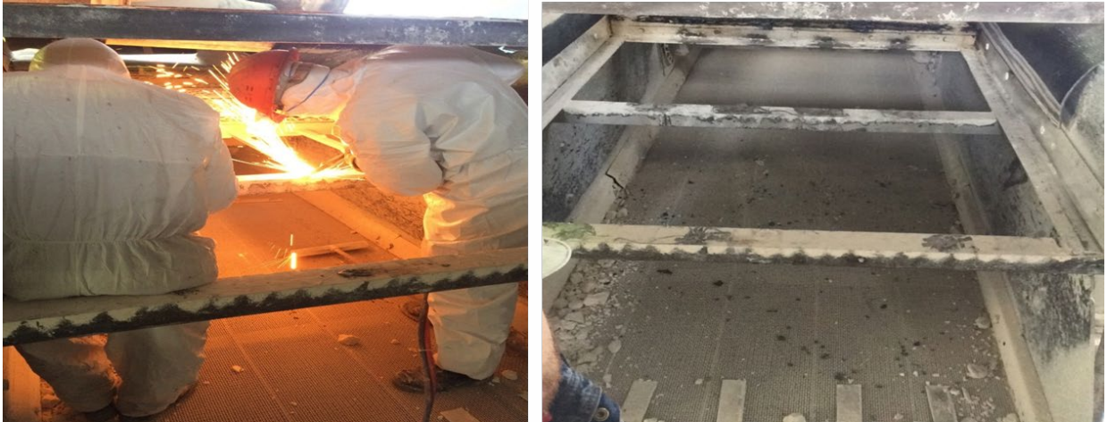
Şekil 8. Çelik esaslı elek panel şaseslerinin kesilerek demontajı anı görünümü
