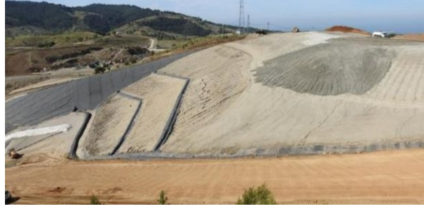
Şekil 17. Filtrelenmiş atık depolama alanında, erozyonun etkisini azaltmak üzere, oluşturulan geçirimsiz su atım kanalları
