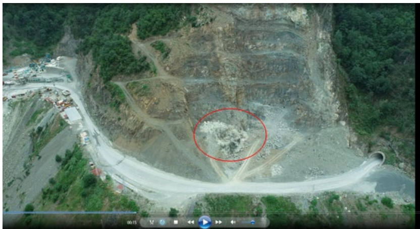
Şekil 7. Elektronik ateşleme ile gerçekleştirilen patlatma görüntüsü
