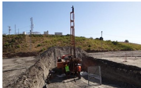
Şekil 34. Filtrelenmiş atık depolama alanı'nda SPT çalışması
