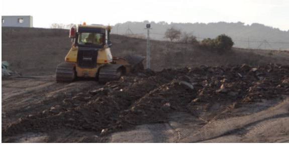
Şekil 7. Atığın nemini azaltabimesi için dozele yapılan ripperleme işlemi.
