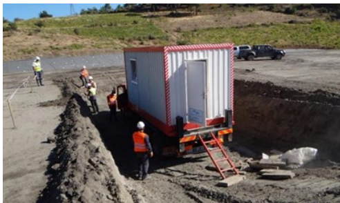
Şekil 33. Filtrelenmiş atık depolama alanı'nda SPT çalışması
