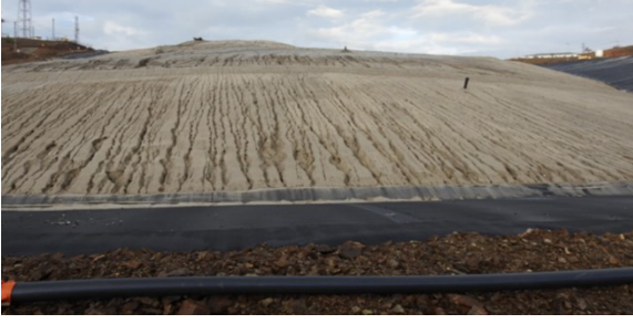
Şekil 15. Kuru atık depolama alanı yüzeyinin yağışlar sonrasındaki erozyon nedeni ile aldığı şekil
