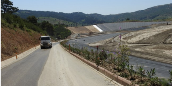
Şekil 28. Asfalt kaplamalı nakliye yolu
