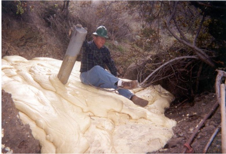
Şekil 10: Poliüretan köpük ürünlerinin uygulama görseli (Frontier, 2018)
