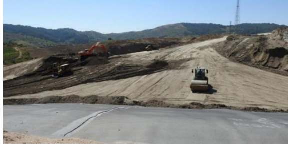
Şekil 9. Yüksek nem içeriğine sahip atık yığınının iyileştirilmesi çalışmaları
