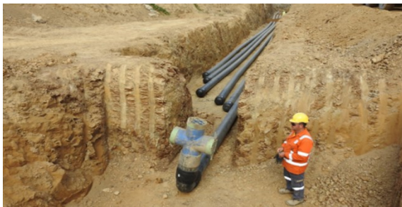
Şekil 18. Su borusu döşeme işleri
