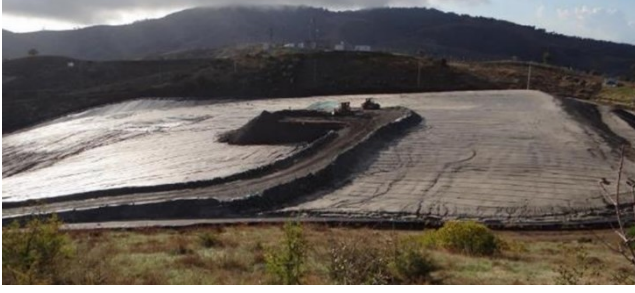
Şekil 23. Kuru atık depolama alanında, kesintisiz nakil sağlamak amaçlı olarak oluşturulan sağlam zemine sahip bölge.
