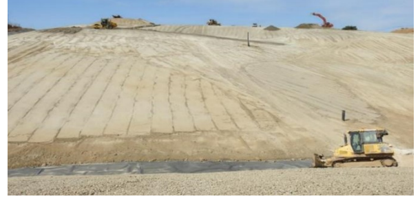
Şekil 24. Malzemenin serim sonrası silindir ile sıkıştırılarak kabuk oluşturulması
