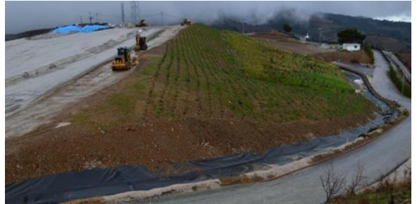
Şekil 31. Nihai duruma ulaşan yüzeylerde yapılan rehabilitasyon işlemi
