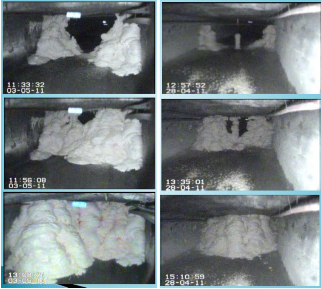
Şekil 8: Yerüstünden yeraltına yapılan kimyasal dolgu çalışması uygulama görseli (Wilson Mining Service, 2019)
