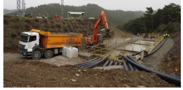
Şekil 16. Sediman yakalama havuzundan çamur temizliği yapılması
