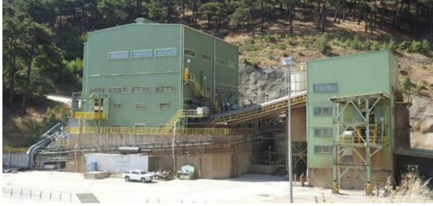
Şekil 1. Efemçukuru Madeni filtre tesisi
