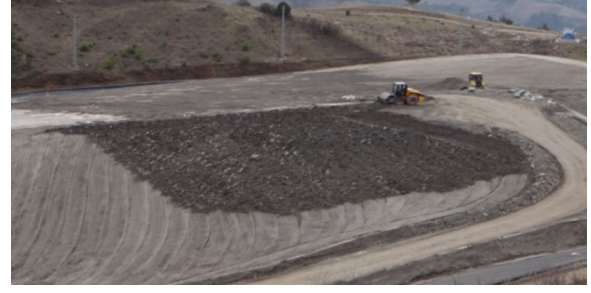
Şekil 8. Nemini azaltmış olan alanın tekrar serilerek sıkıştırılması.
